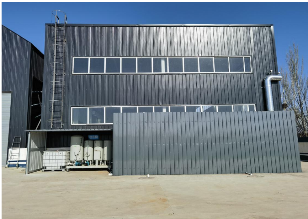
图 3-3 废水处理设施
